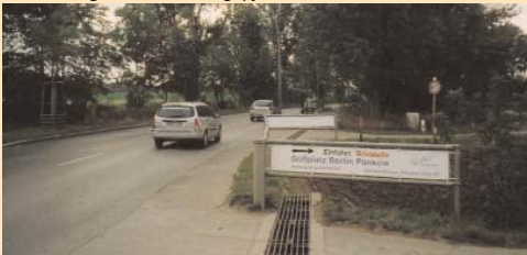
► Einfahrt zur Baustelle
