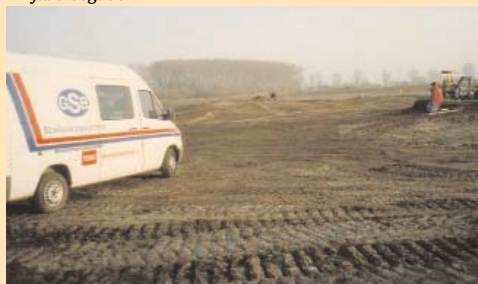
► Einbau der Beregnungsanlage
