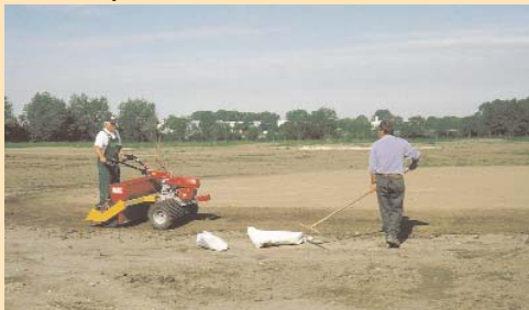
► Einbau des Substrates
