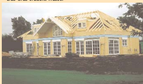
► Das Clubhaus wird aufgebaut
