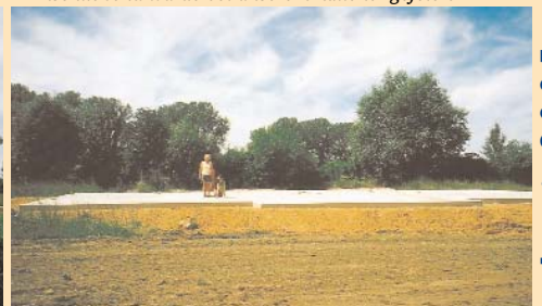
► Die Bodenplatte für das Clubhaus steht
