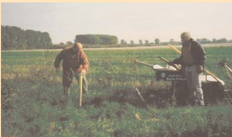
► Erstes Abstecken des Geländes
