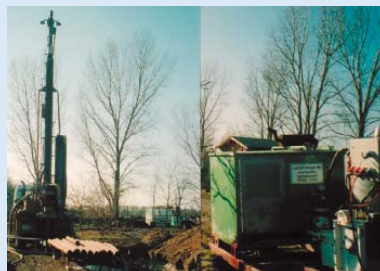
● Ein Grundwasser-Tiefbrunnen entsteht für die Bewässerung
