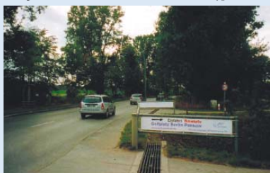
● Die Einfahrt zur Baustelle am Blankenburger Pflasterweg 40
