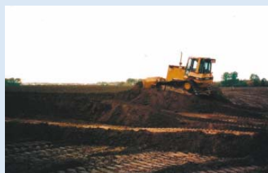
● Die ersten Geländemodellierungen: Hier entsteht das Grün 2
