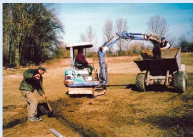
● Drainagen werden angelegt
