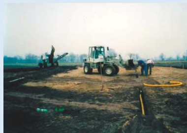
● Die ersten Drainagen werden gelegt
